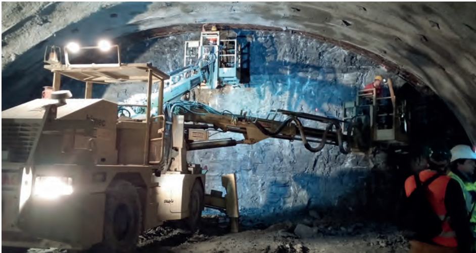
Bohren von Sprenglöchern für Kalottenvortrieb Brenner-Basis-Tunnel 2015. (Foto: P. Kudella, KIT)
