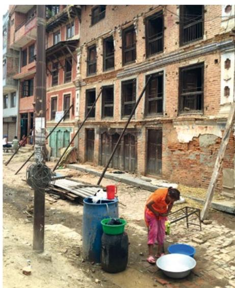
Mit Stützpfählern notdürftig stabilisierte Wände an vom Erdbeben beschädigten Häusern.
