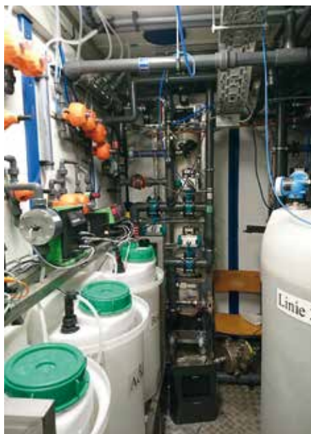
Pilotanlage zur Ultrafiltration am Versuchstandort des ZVK Steinhäule in Neu-Ulm. (Foto: Dr.-Ing. Johannes Alexander, IFG)
