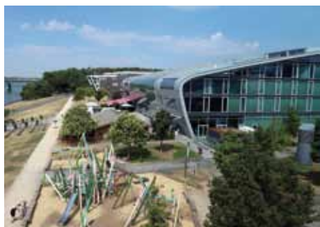
Umweltschonend heizen und kühlen: Ein Hotel und zwei Bürogebäude am „Bonner Bogen“ setzen auf einen Aquiferspeicher – eines von bisher nur vier Beispielen in Deutschland. (Foto: Paul Fleuchaus)
